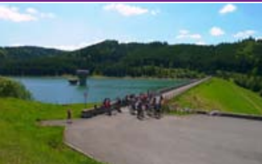
Stanovnice water reservoir
